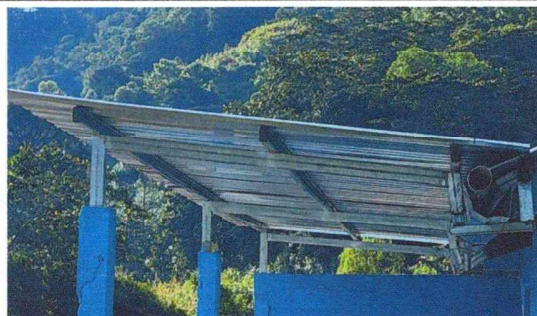
Foto 4: Cocina: Sustitución de Láminas dañadas por Lámina Troquelada cal. 26 y sustitución de estructura de techo de madera sustituida en su totalidad por estructura de metal.
