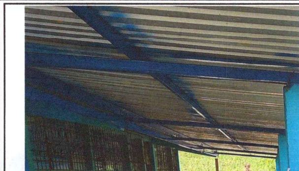
Foto 1: Módulo 1: Mantenimiento a Estructura de techo completamente concluido.
