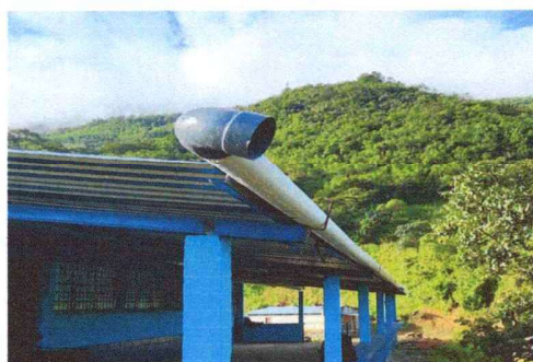
Foto 2: Módulo 1: Canales de agua pluvial concluidos.
